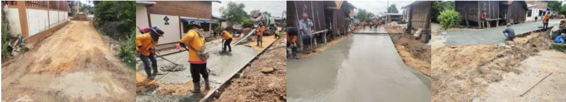
โครงการก่อสร้างถนนคอนกรีตเสริมเหล็ก จากปากซอยบ้านนางสมัย – บ้านนายรนากร หาดทะเล หมู่ที่ ๖ บ้านกุดจอกน้อย
