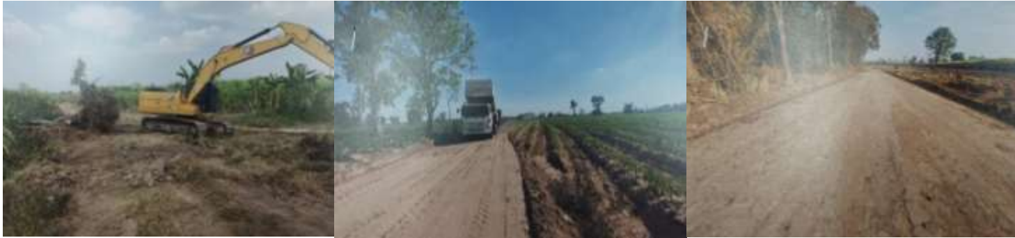
โครงการก่อสร้างถนนมูลดิน สายหนองตะแบก – หนองโพธิ์ หมู่ที่ ๓ บ้านละลม
