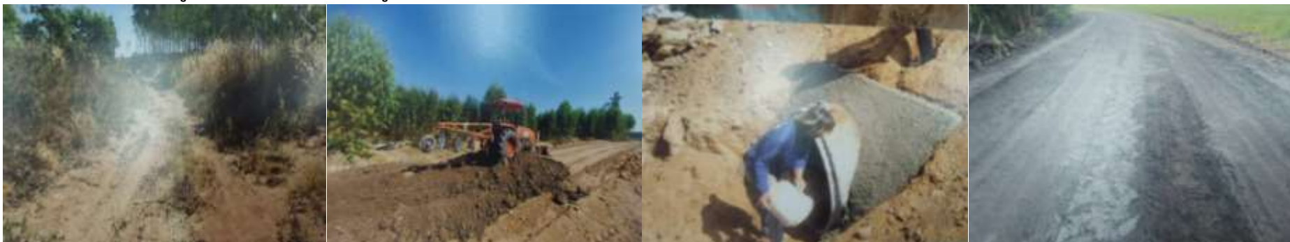
โครงการก่อสร้างถนนมูลดิน สายหนองสะแก หมู่ที่ ๒ บ้านละลม
